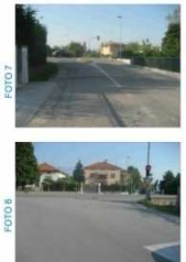
Punto D: scarsa sicurezza nell'attraversamento. Difficoltà di immersione per pedoni e ciclisti da via dei Masi.
