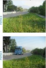
Punto B: mancanza di visibilità e assenza di protezione in curva per l'immersione di pedoni e ciclisti da via Molino al percorso protetto.
