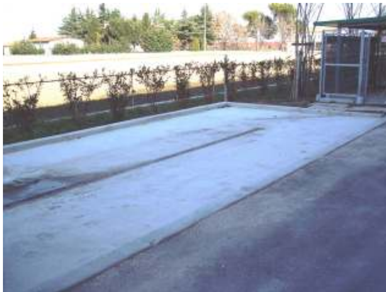
Foto 9 – Piazzola sosta autocisterna rifornimento pentano 9010
