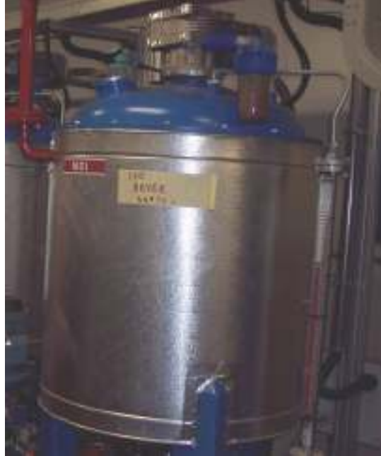
Foto 5 – Serbatoio intermedio del polimetilen polifenil isocianato
