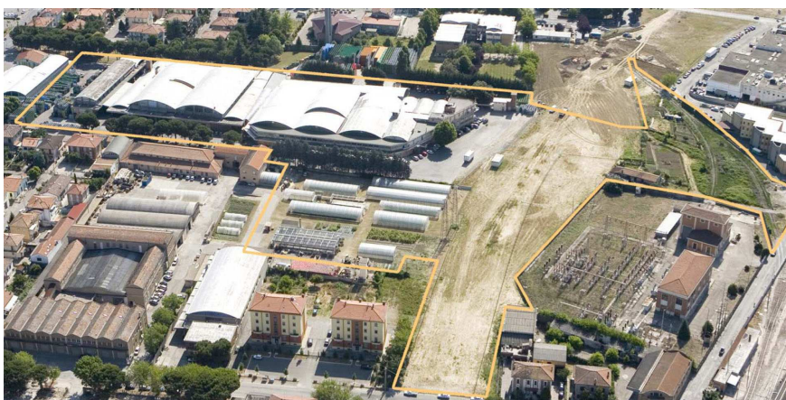
Fig. 4.1 - Area ex AGRIFRUIT e sottostazione elettrica
