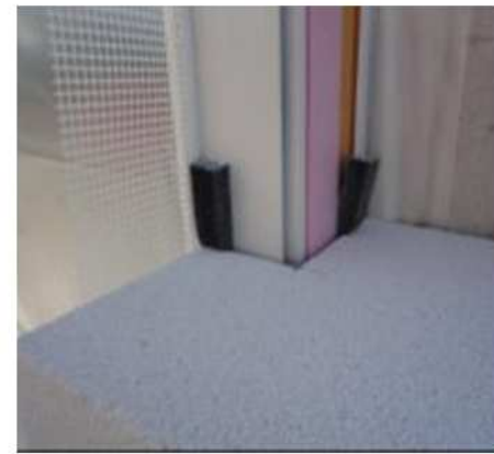
Portoncino ingresso U = 0,75 \text{ W}/(\text{m}^2\text{K})
