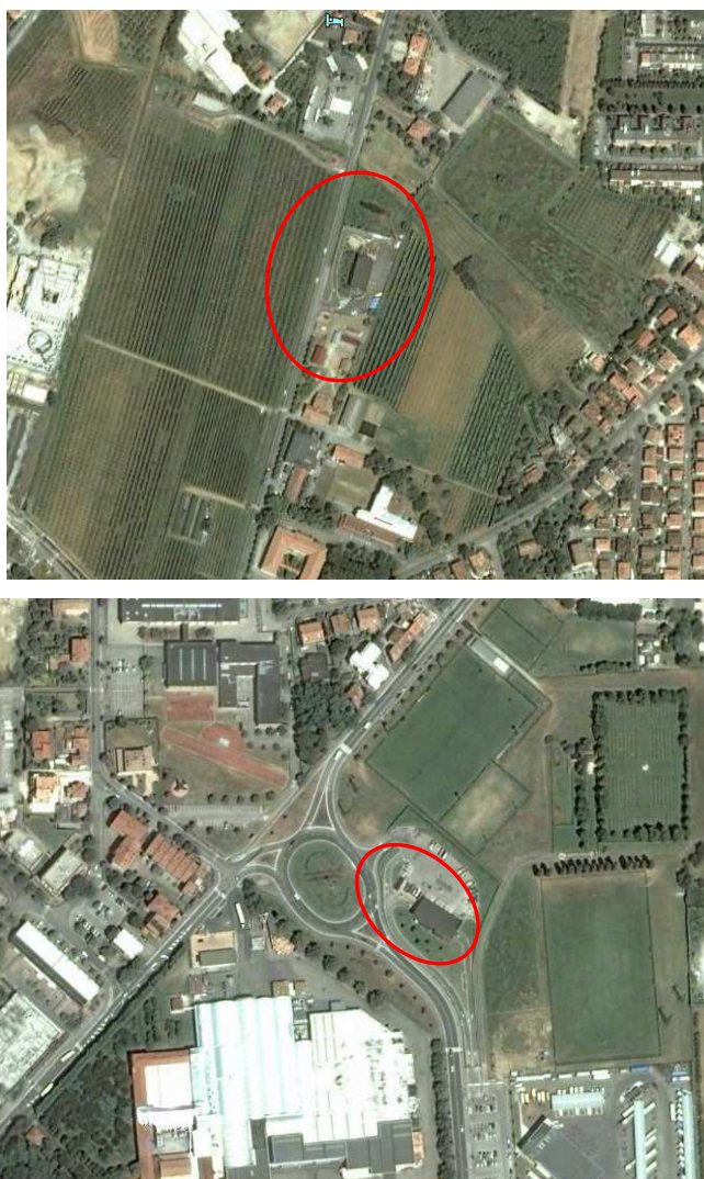
Fig. 1.12 – Vista aerea delle due Stazioni Ecologiche Attrezzate (SEA) di Via Romea e di Via A. Spinelli.
