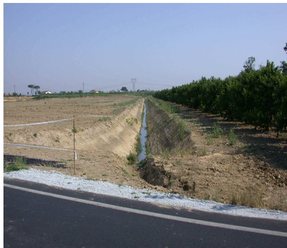
Figura 3.8 – Vista del canale di scolo "Rigoncello" coincidente al confine orientale del comparto
