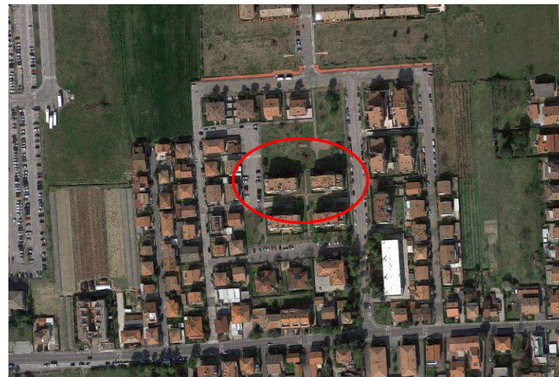
Fig. 6.1 – Vista aereofotogrammetrica area
