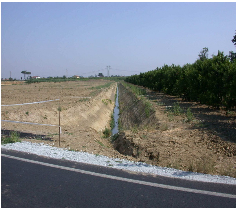
Vista del canale di scolo "Rigoncello"
