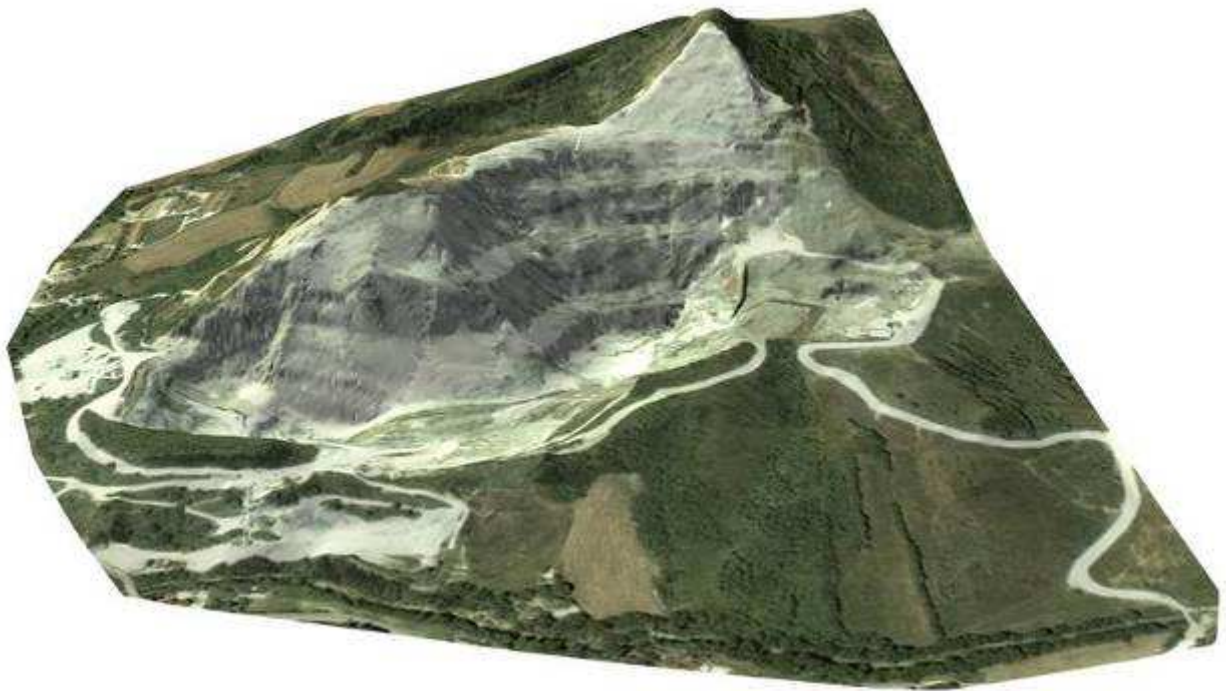
Figura 3.5.1-6 - Render fine termine escavazione anno 2024 (visuale dal crinale in località Polverella-Sodo in Comune di Torriana)
