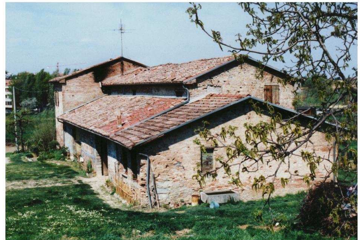
Foto n. 4 - Vista del fianco est da sopra la scarpata
