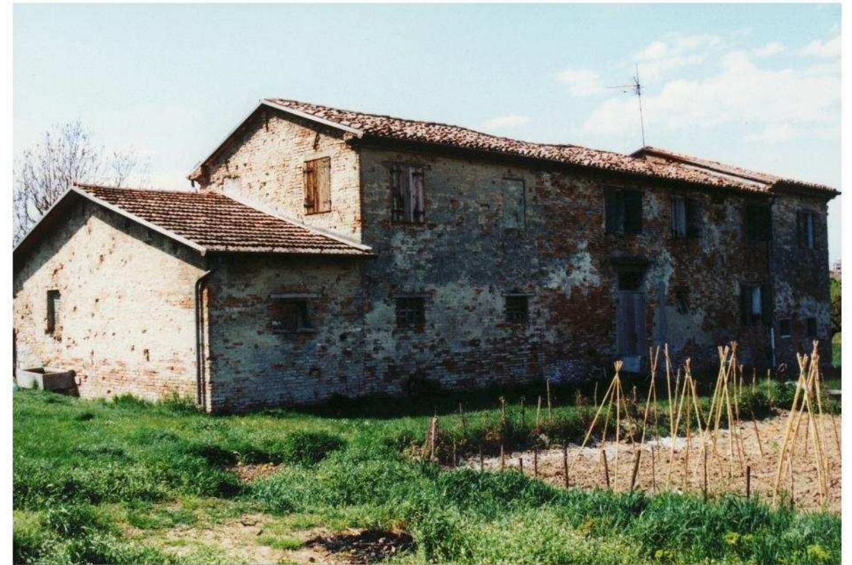
Foto n. 3 Vista del retro
