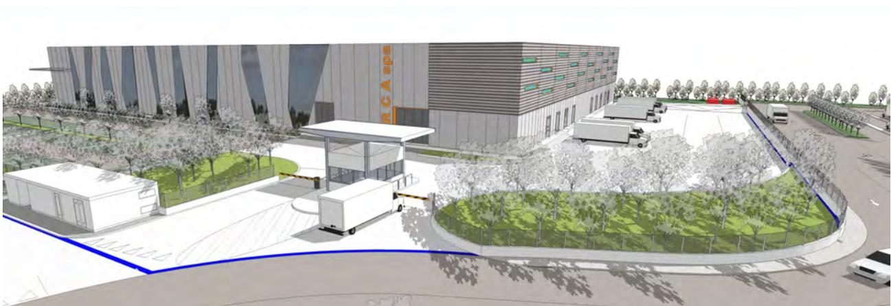
L'edificio è costituito da un'unica piastra, ad un piano, nella quale si organizzano il magazzino e gli spazi accessori necessari (aree di carico/scarico, locale infiammabili, locale magazziniere, ecc.). Sul lato est, in una zona all'esterno accessibile dal parcheggio privato, vengono posizionati i carrelli e i relativi spazi per la ricarica delle batterie.
