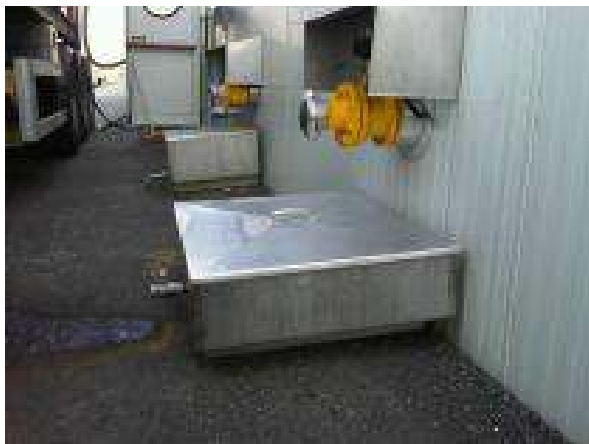
Foto 10 – Vassoio raccolta perdita accidentali durante lo scarico isocianato e poliolo
