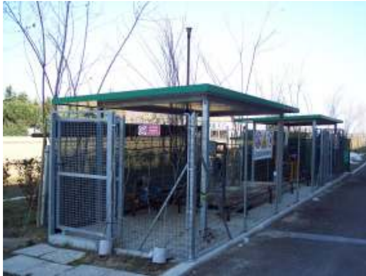
Foto 3 – Recinzione del serbatoio orizzontale pentano 9010 interrato
