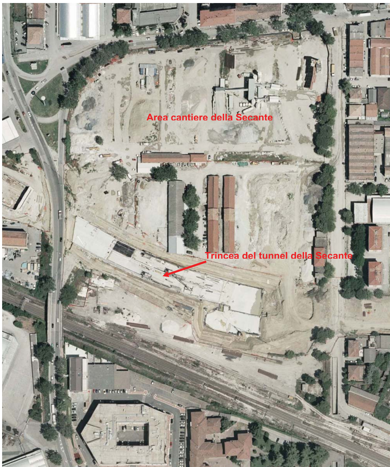
Immagine 11: Foto aerea dell'area del mercato durante la realizzazione del tunnel della Secante
