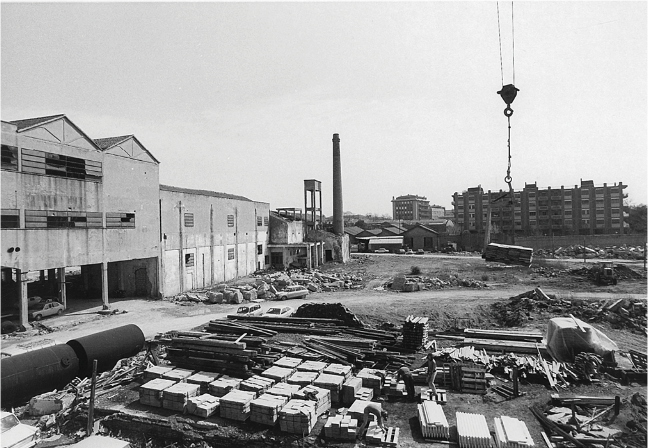
Immagine 36: Foto durante il cantiere per il recupero dello stabilimento alla fine degli anni '70
