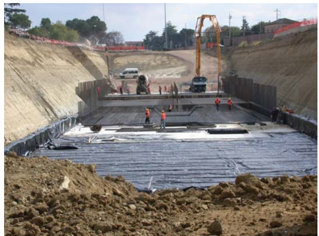
Immagine 38: Il cantiere della Secante lungo via Trovanelli
