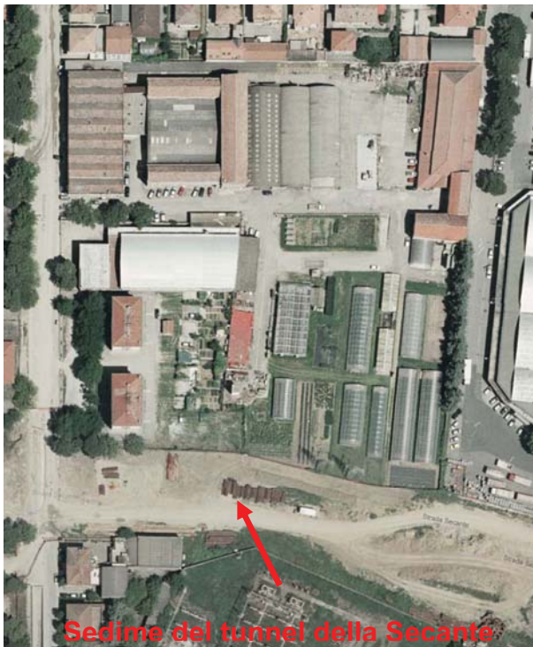
Immagine 18: Foto aerea dell'area SAIS durante la realizzazione del tunnel della Secante
