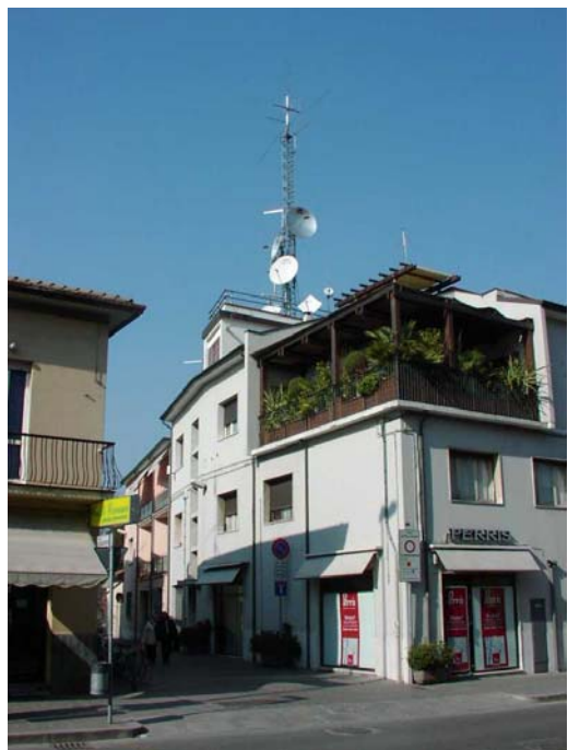
Foto n.1 - Installazione che ospita solo ponti radio
