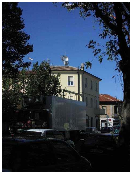
Foto n.1 - Edificio con installazione sul tetto
