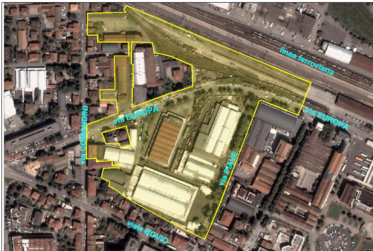
foto aerea dell'area di intervento (area tratteggiata di colore giallo) in cui si è già proceduto alla demolizione dei fabbricati esistenti (la fotografia risale all'anno 2002 per cui presenta ancora i fabbricati recentemente demoliti)
