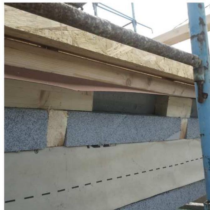
SOLAIO CONTRO TERRA | Isolamento con XPS sp.10cm
