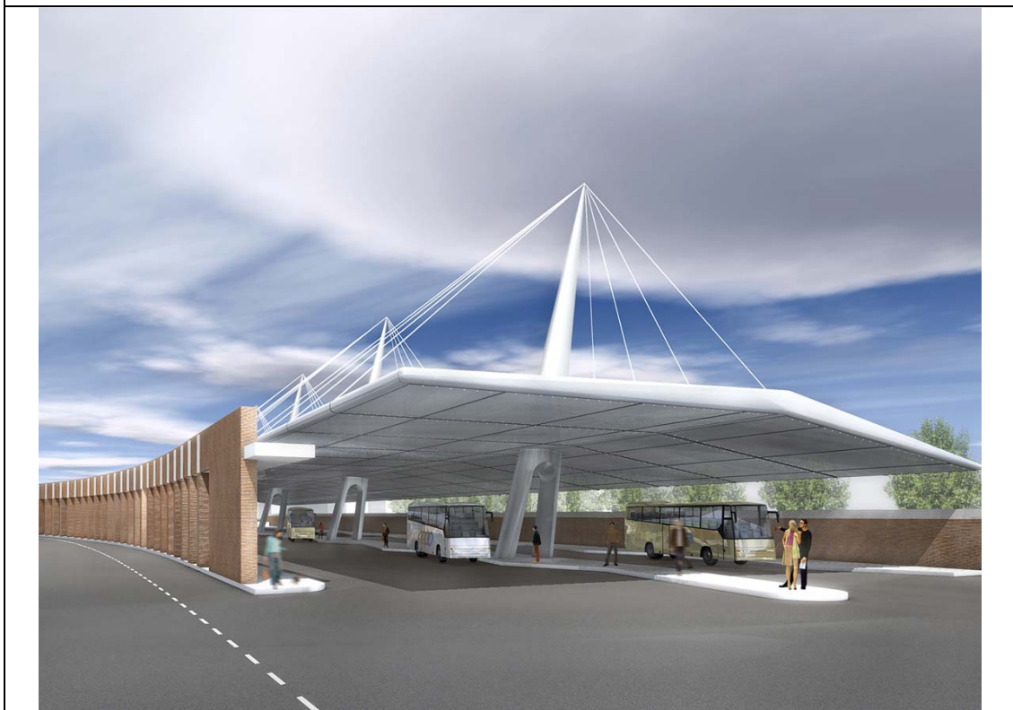
VISTA INGRESSO STAZIONE CORRIERE
