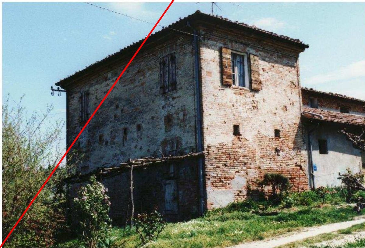
Foto n. 2 - Vista del fianco ovest dalla strada d' ingresso
