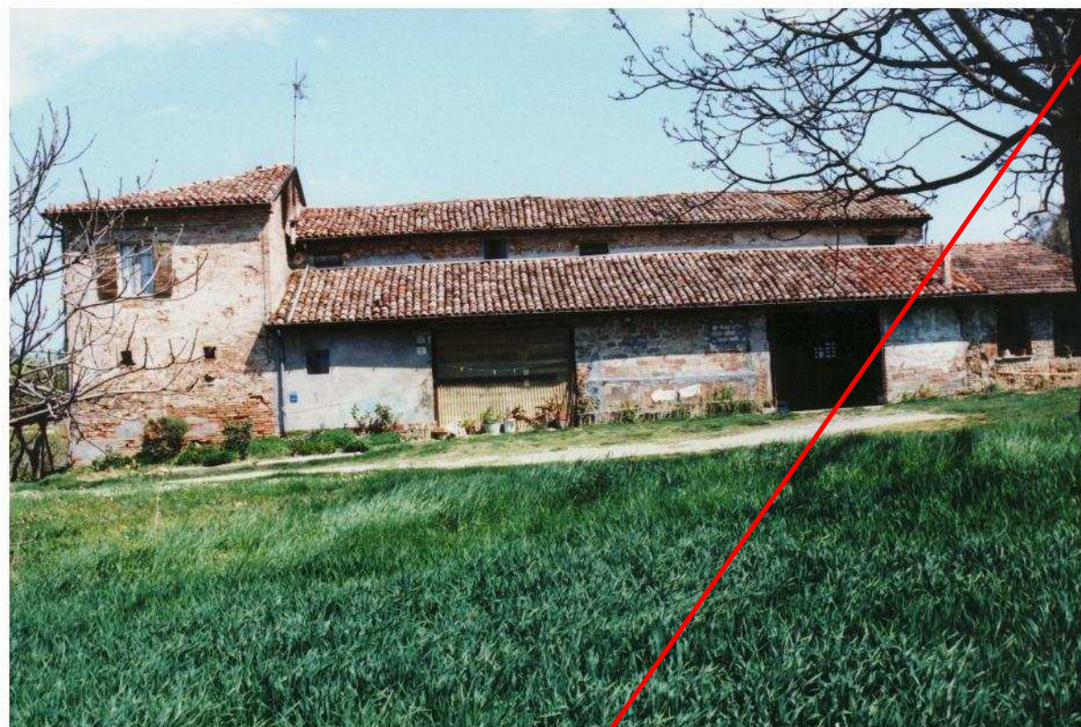
Foto n. 1 Vista del fronte
