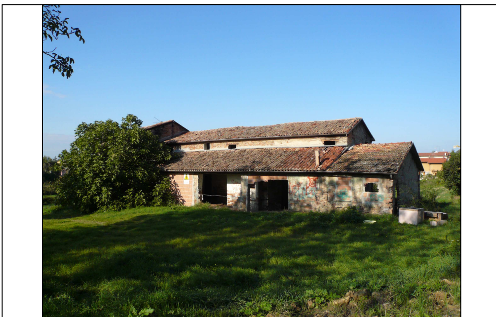
Vista della facciata
