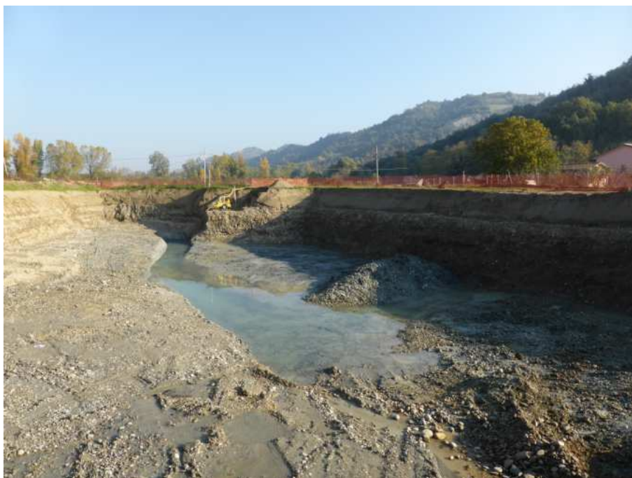
Vista lotto di scavo sud est
