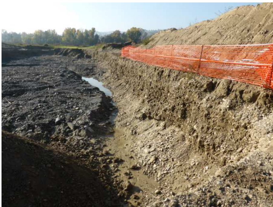
Vista lotto di scavo nord est
