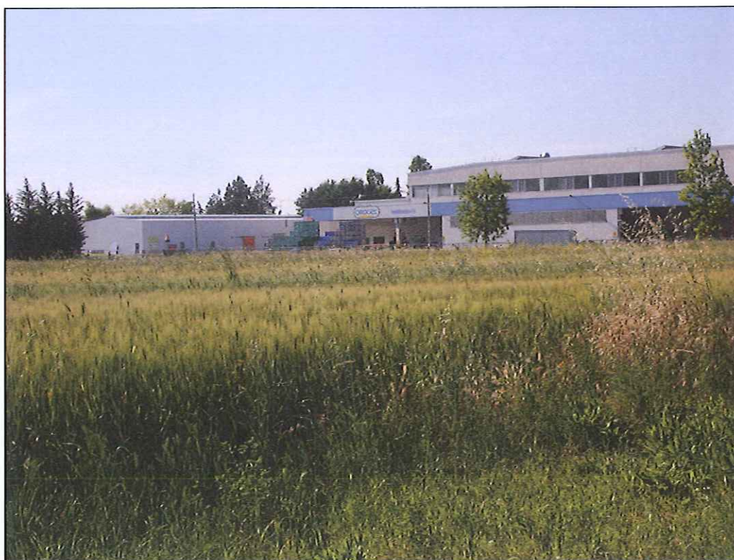
FOTO 06 Vista del comparto dalla via Dismano; orientamento della veduta nord-ovest
