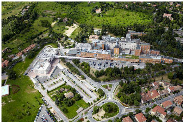
Ospedale Bufalini – oggetto di delocalizzazione
