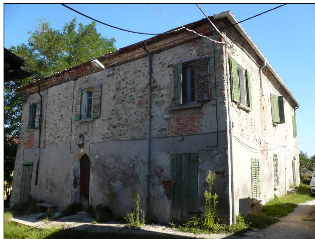
Fotografia ripresa da Via Castiglione
