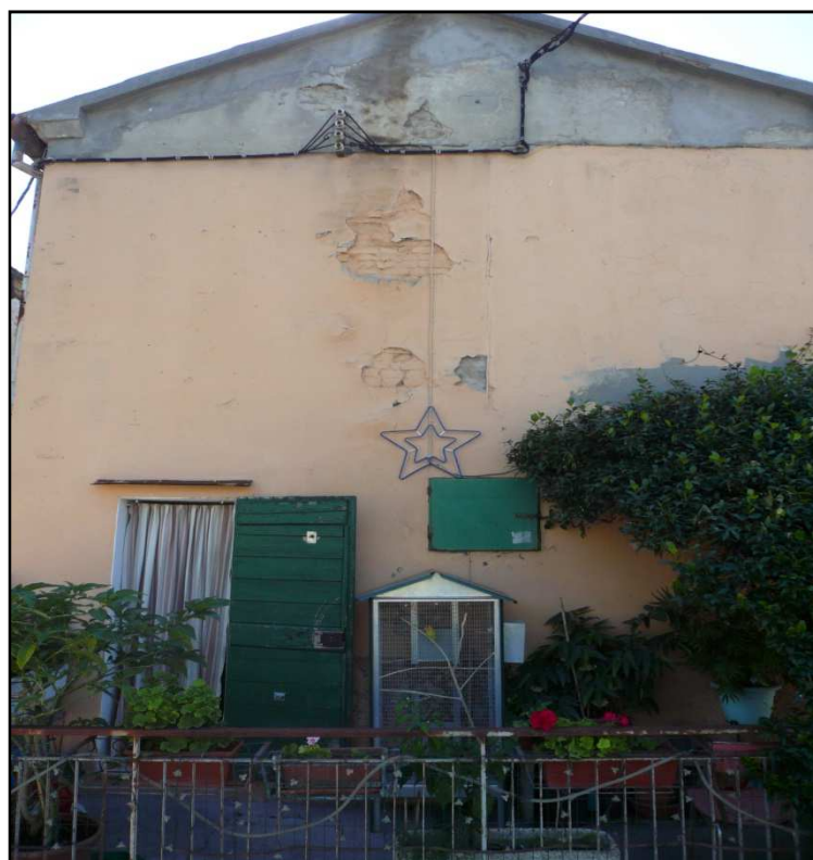
Fotografia ripresa da Via Castiglione
