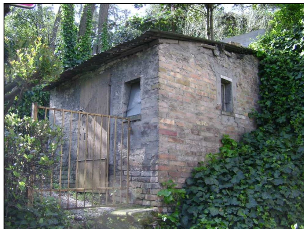
Fotografia ripresa da Via Del Tunnel
