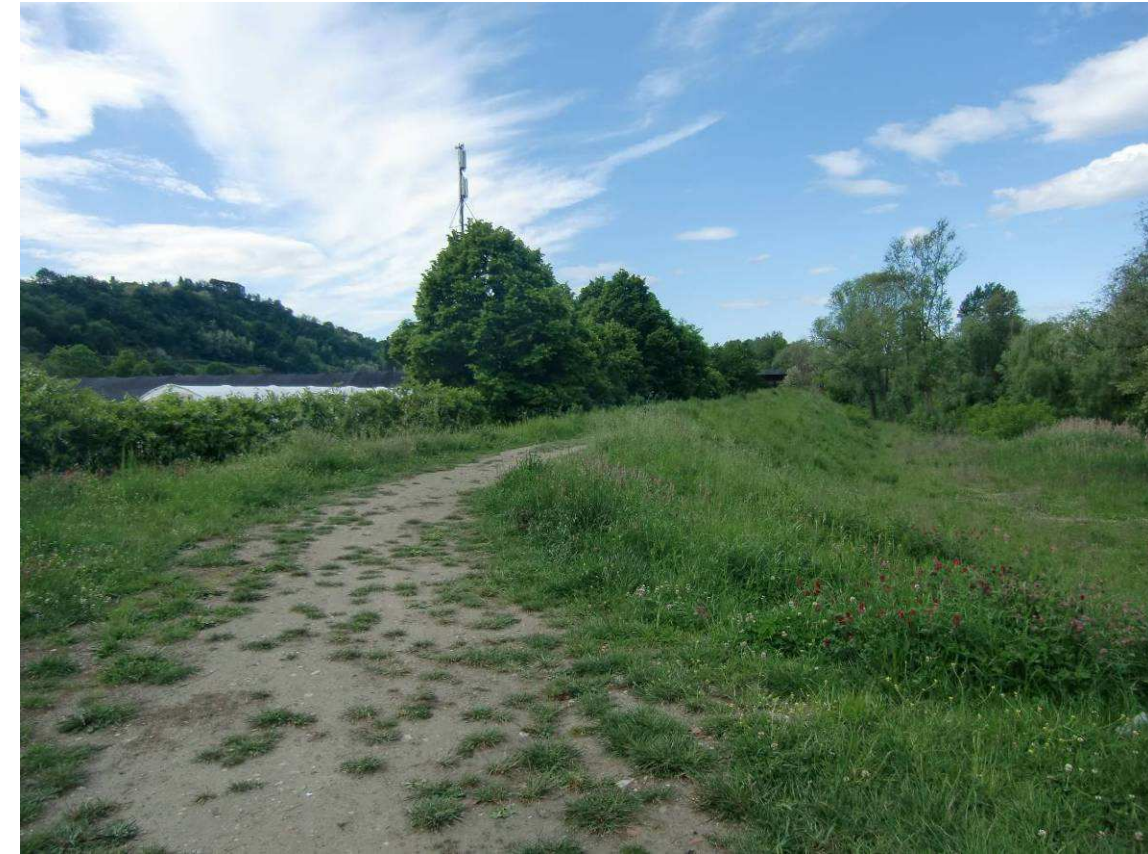
Fig. 10 - Tratto ciclovía su porzione sommitale argine (area intersezione Via Arno - Maceri)
