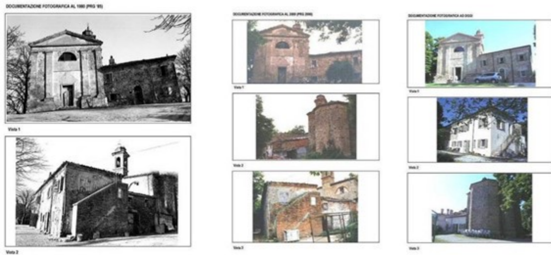
Figura 172 - Edificio vincolato nel PRG 2000, prima e dopo il recupero
