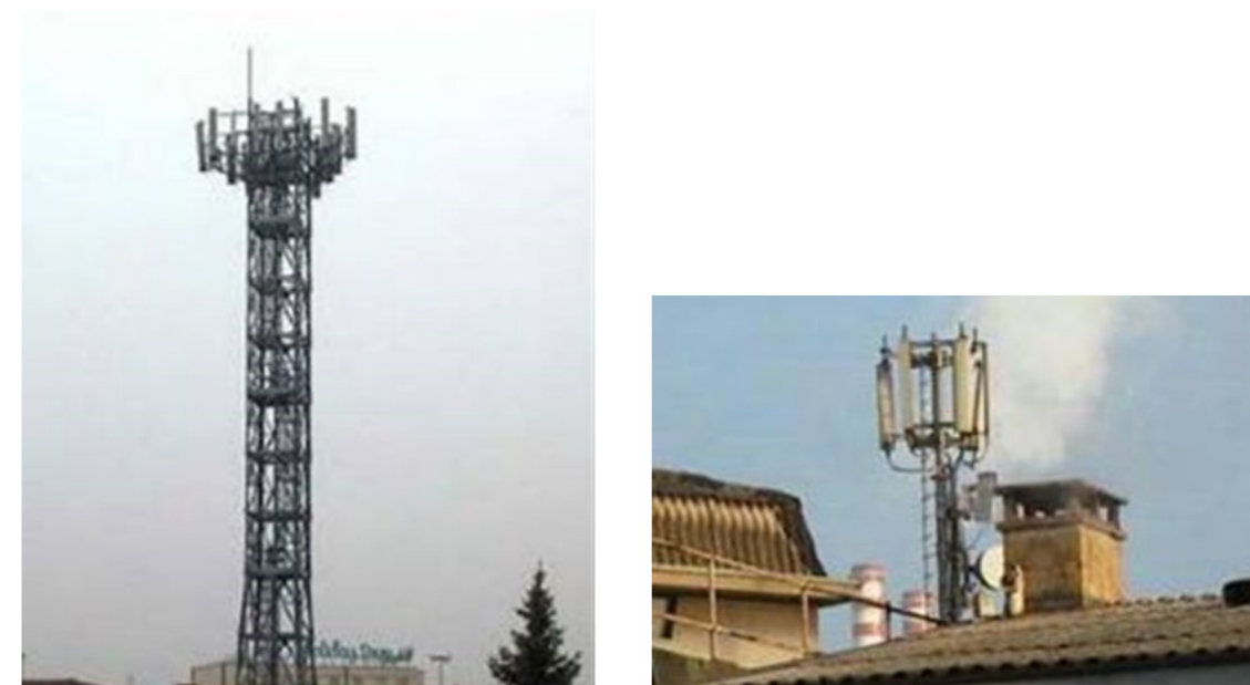
Figura 94 - Tipologie di installazioni SRB
