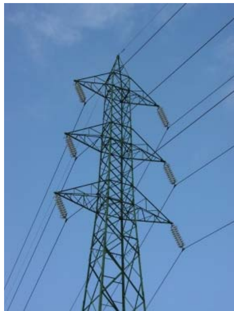
Linea elettrica a 380 kV (a sinistra) e a doppia terna (a destra)
