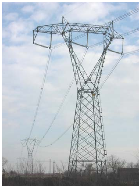
Linea elettrica a 380 kV (a sinistra) e a doppia terna (a destra)
