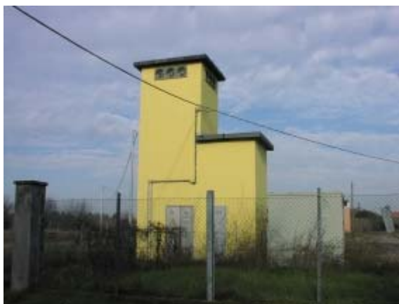
Figura 33 – Cabina elettrica MT/BT(a sinistra) e Trasformatore MT/BT (a destra)
