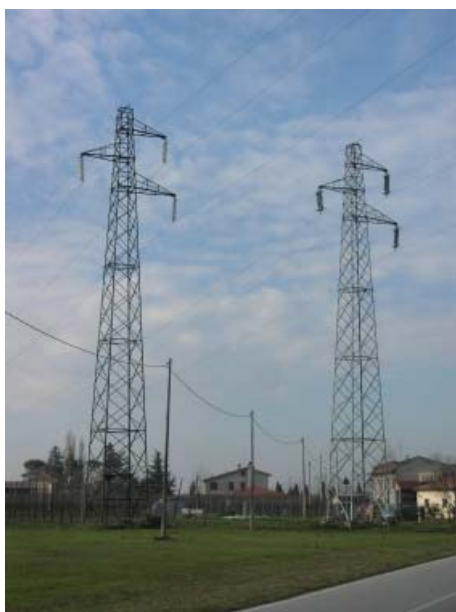
Figura 31 - Linea elettrica a 132 kV (a sinistra) e a 15 kV a conduttori nudi (a destra)
