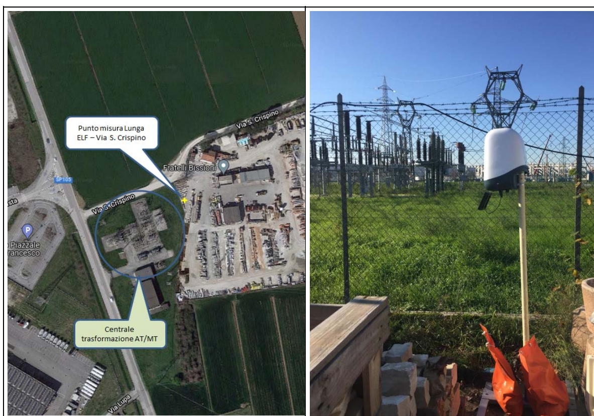
Figura 37 – Collocazione della centralina di monitoraggio della centrale AT/MT all’interno dell’area cortilizia della Ditta Bissioni, Via San Crispino – Cesena
