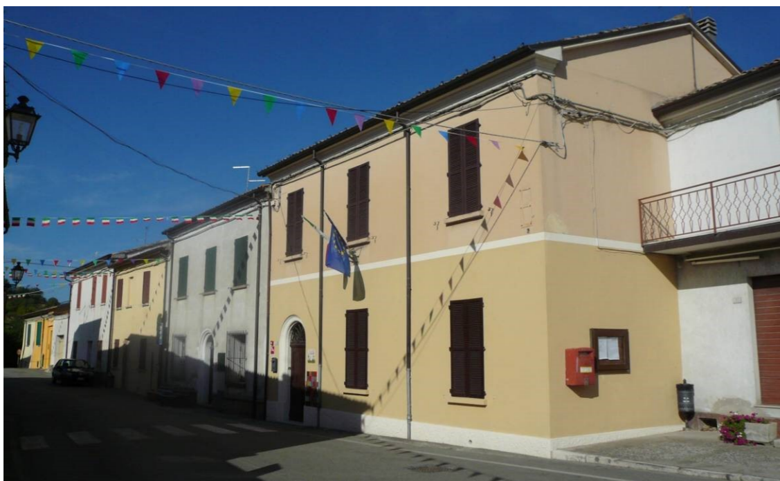
Figura 45 – Scuola dell'infanzia a Montenovo
