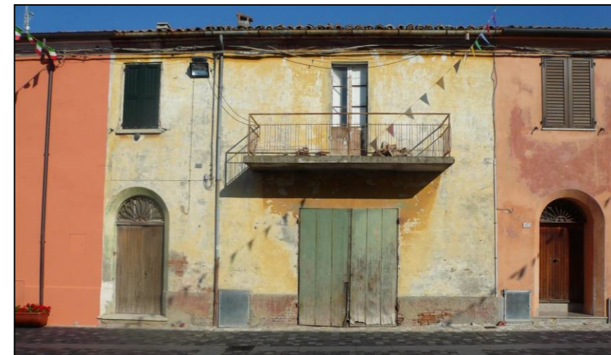
Figura 8 – Montenovo, via Castello Montenovo 45.
