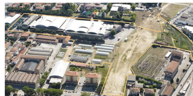
Figura 37 - Area ex APOFRUIT e sottostazione elettrica
