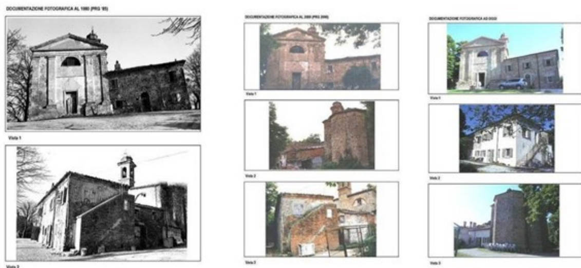
Figura 171 - Edificio vincolato nel PRG 2000, prima e dopo il recupero
