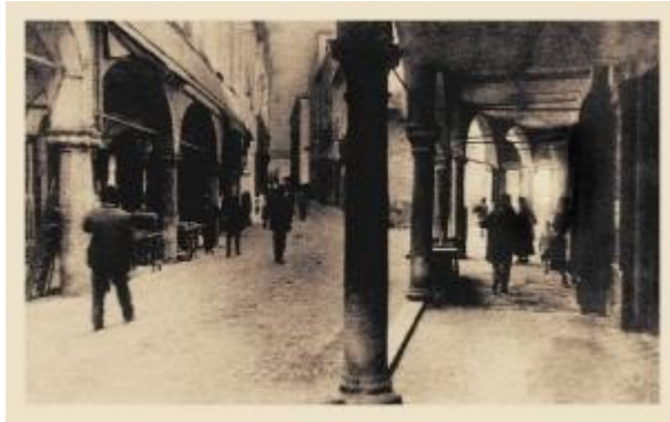
L'edificio al trivio di via Zeffirino Re prima di essere fatto saltare
