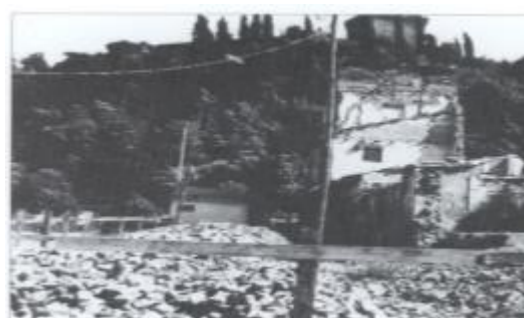
Distruzioni nella zona intorno a San Domenico.
