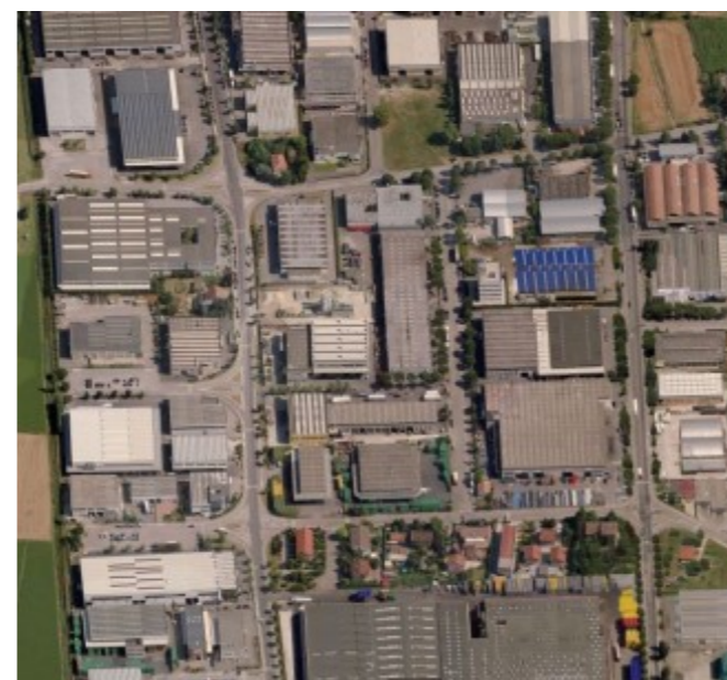
Figura 84 - Vista aerea della zona artigianale di Pievesestina
