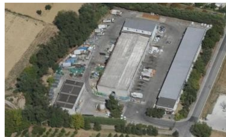
Figura 134 - Ex deposito Hera a Ponte Abbadesse; dopo il trasferimento delle attrezzature di Hera, gli immobili sono stati utilizzati in parte dal Comune come archivio
