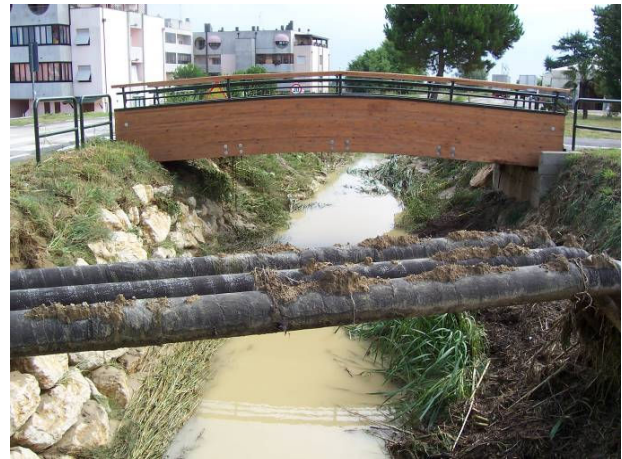
Esondazione 16/09/2006, (valle del ponte via Emilia)
